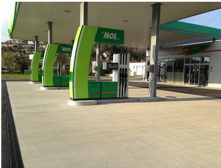
Slika 2: Betonski tlak med točilnimi mesti bencinskega servisa MOL v Rožni Dolini
