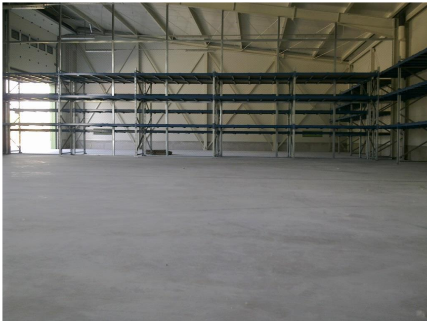
Slika 3: Tlak v montažno skladiščni hali podjetja Plinovodi v Budanjah pri Ajdovščini
