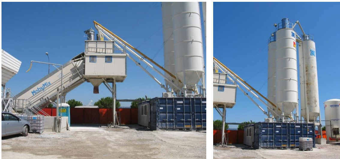
Slika 5 (levo) in 6 (desno): Betonarna na gradbišču tunela Markovec (Vir: fotoarhiv Rokava d.o.o.)
