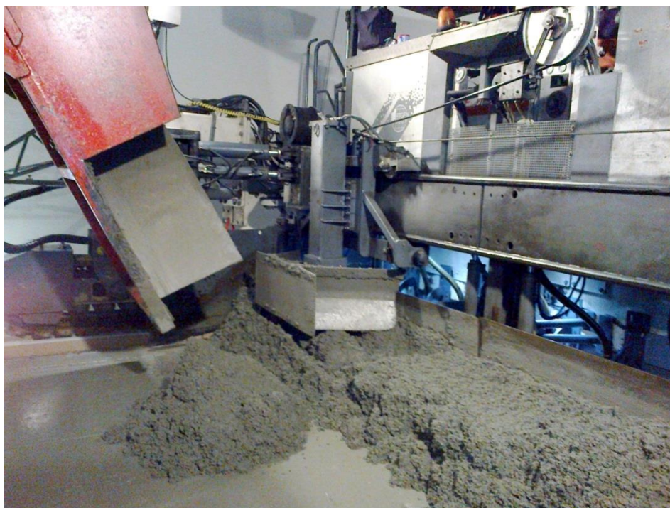
Slika 4: Betoniranje vozišča (Vir: fotoarhiv Rokava d.o.o.)
