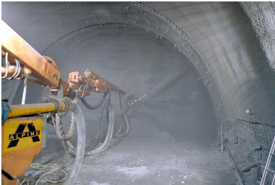
Slika 3: Utrjevanje hribine z brizganjem betona (Vir: fotoarhiv Rokava d.o.o.)
