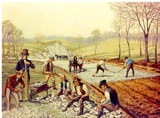
Slika 8 Gradnja prve makadamske ceste v Združenih državah Amerike (1823). V ospredju delavci drobijo kamne (Vir: Wikipedia)
