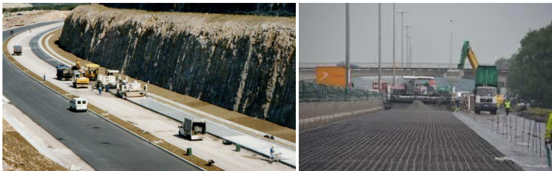
Slika 9 Levo JPCP v Sloveniji (Vir: avtor) Desno: CRCP v Belgiji (Vir: Wikipedia)
