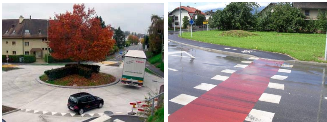
Slika 10 Levo KK v asfaltu (Vir: R. Bašelj) Desno: JPCP KK v Švici (Vir: [6])
