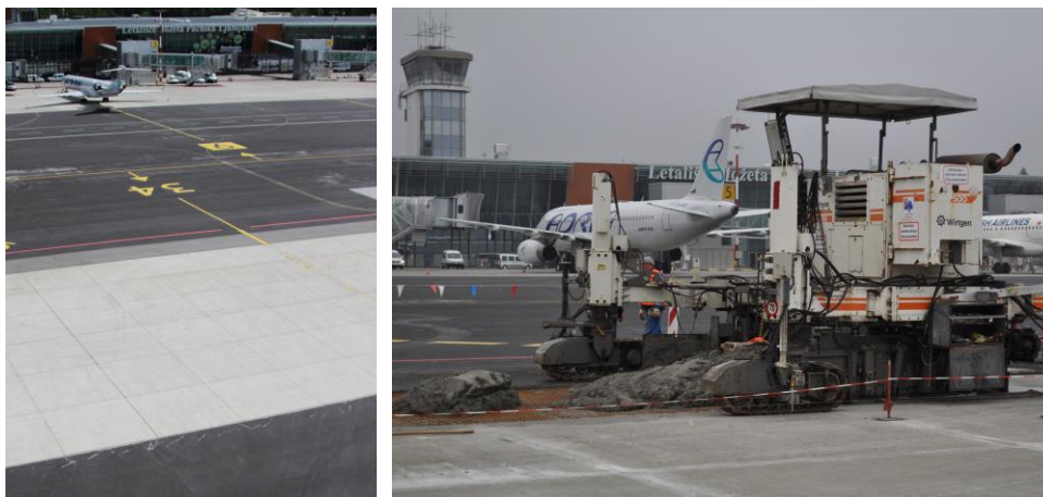
Slika 7 Levo: Parkirne pozicije na glavni letališki ploščadi Desno: Vgrajevanje obrabne plasti betona (Vir: avtor)
